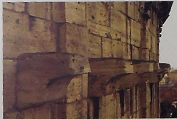
Prospetto settentrionale dell'Anfiteatro: mensola di sostegno della struttura di copertura mobile della cavea ( velum )
