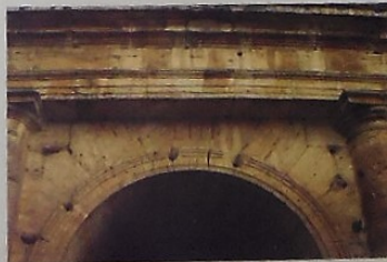
Numerazione originale (LIII) su una arcata di accesso all'edificio
