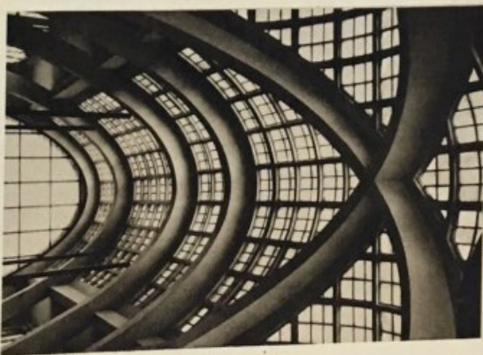
Coiffement des voiles de béton. The Crossing of a Beton Arch.
