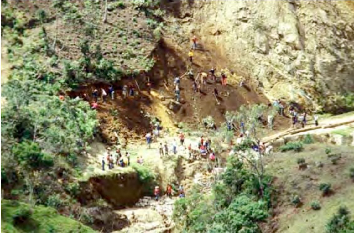
Foto 47: Minga de guambianos y paeces para arreglo de un puente en Juanambú
