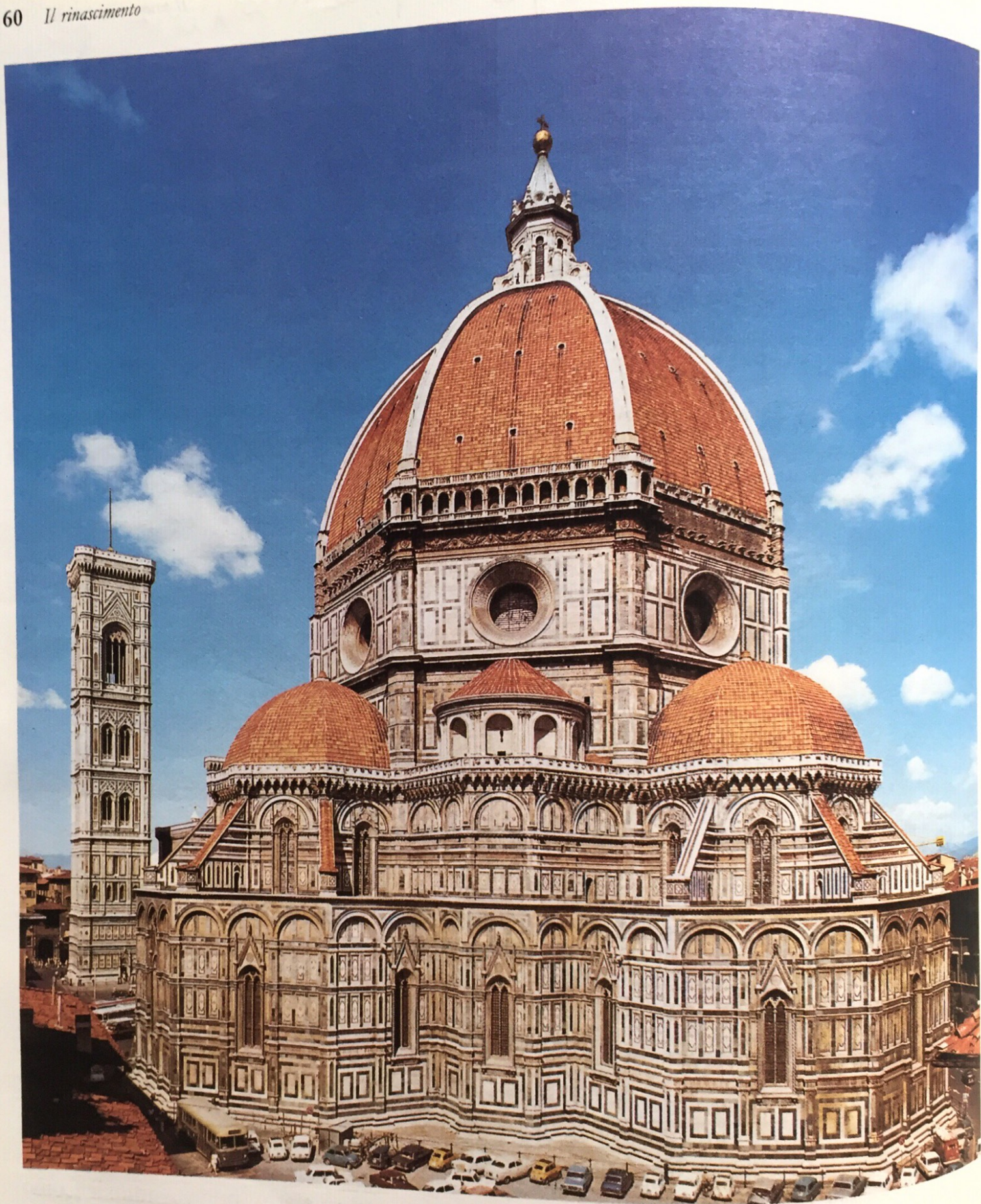
29. Filippo Brunelleschi, Cupola del Duomo di Firenze; 1420 sgg.; alt. m 105,50 da terra, diam. m 51,70. Per la costruzione d'u
