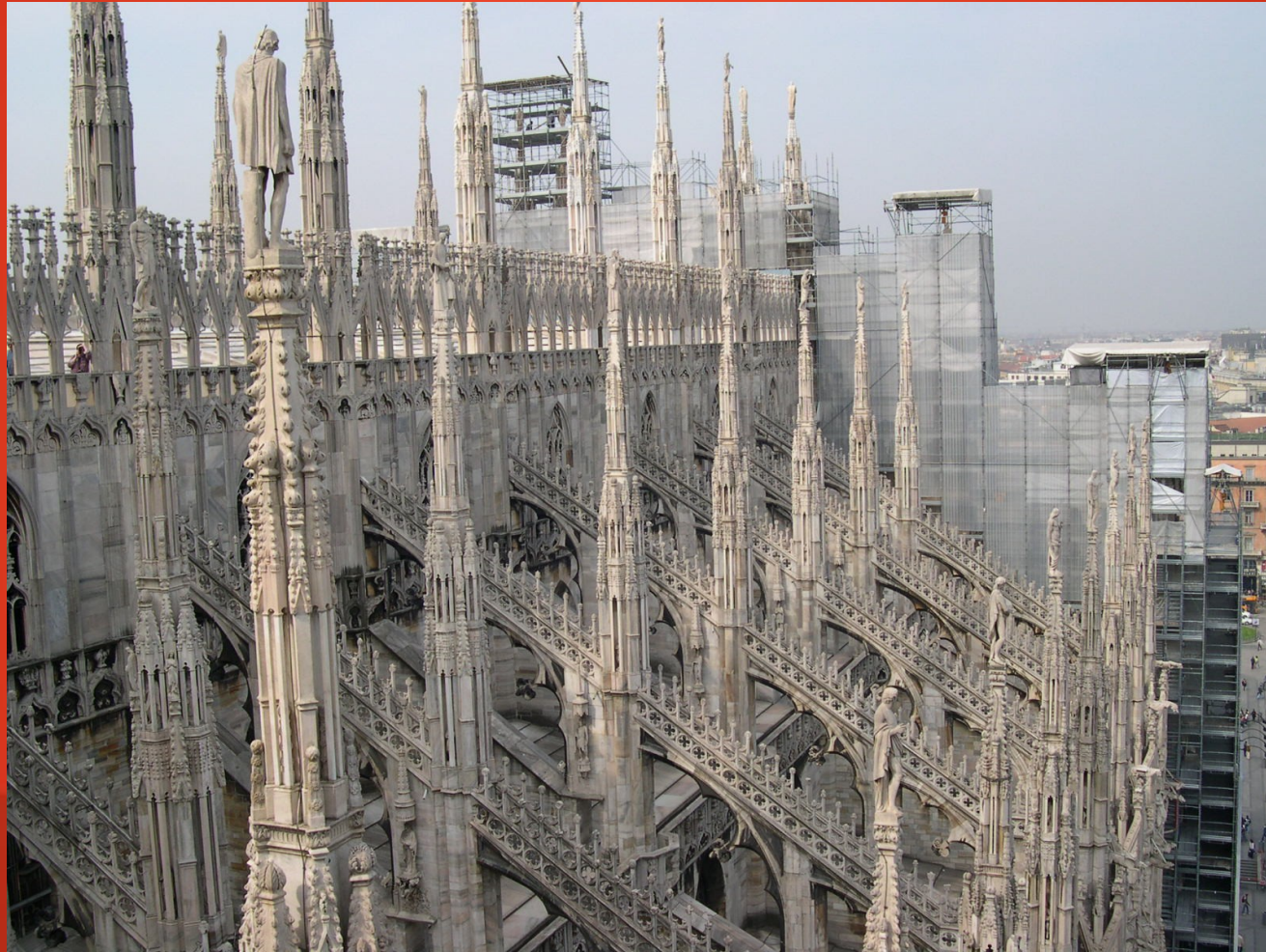
Vnější opěrný systém dómu v Miláně
