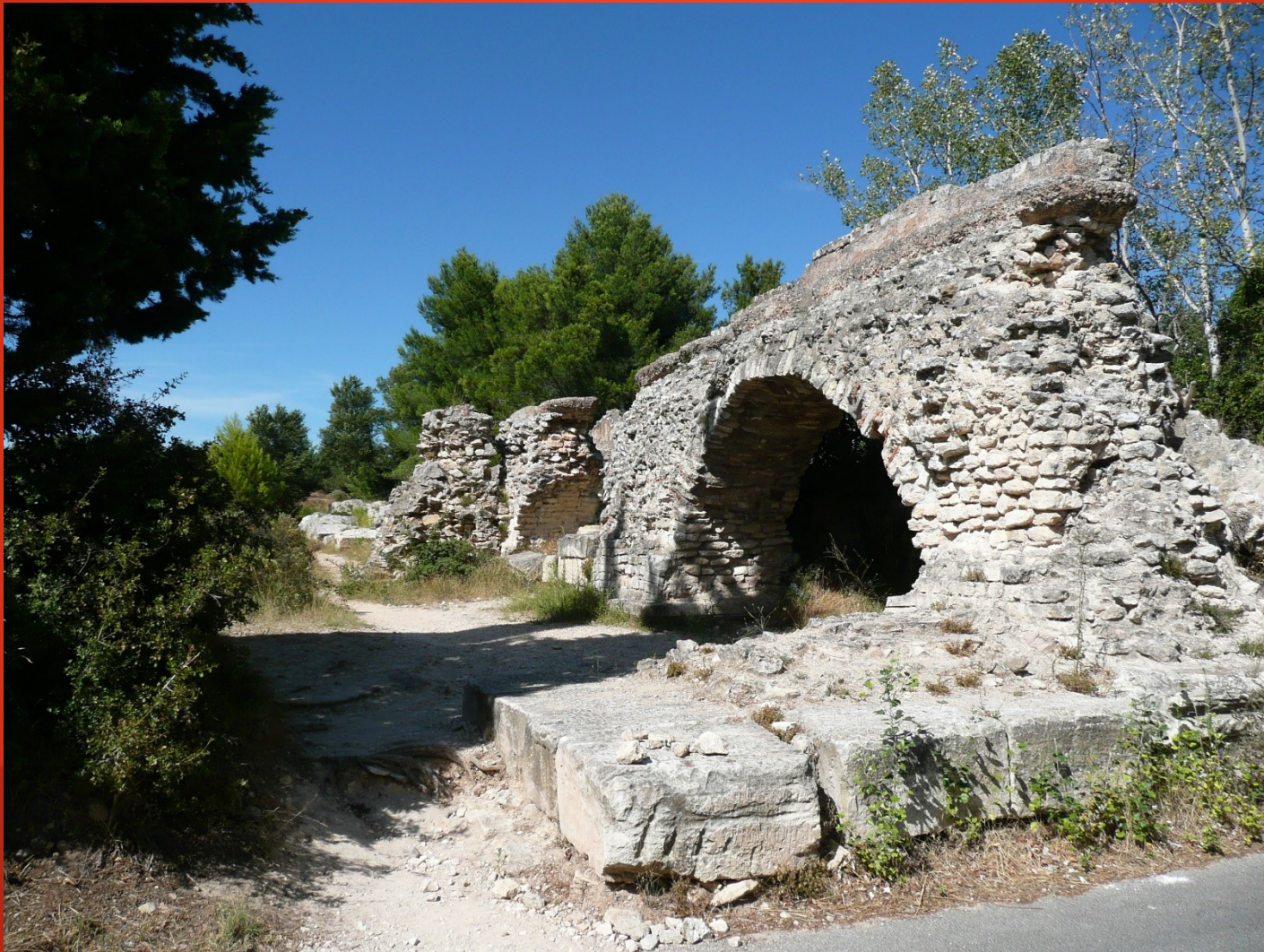
Barbégal – zbytky přívodního akvaduktu
