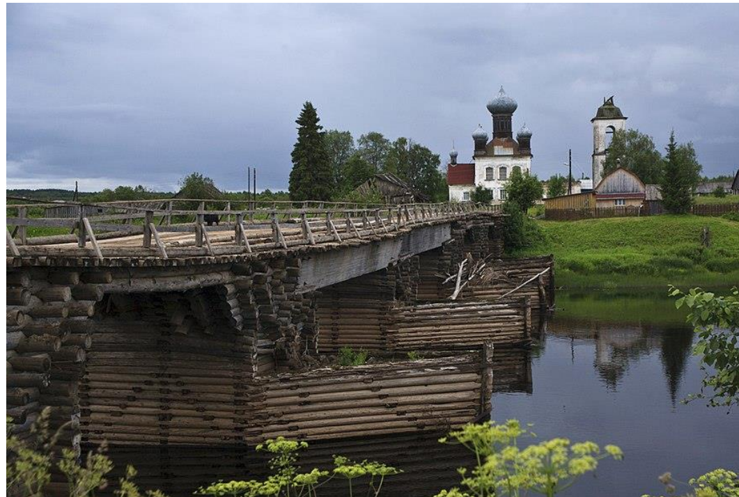
Most přes ř. Kenu, Archagelská oblast
