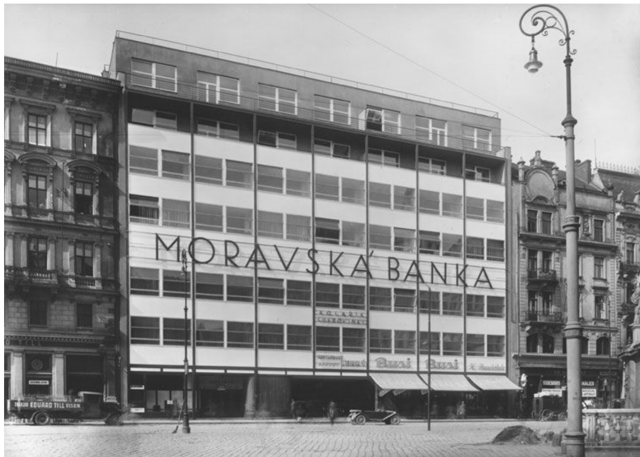
Zavěšená fasáda, doplněná opaxitovými tabulemi (Bohuslav Fuchs, Ernst Wiesner, 1930)
