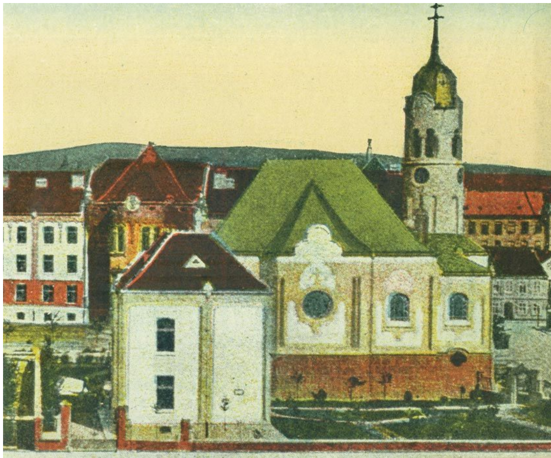
Pohlednice naznačující původní barevnost fasád
