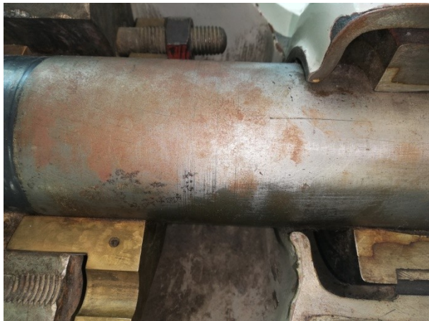
Slabé vrstvy rzi vlivem lokálního znečištění povrchu
