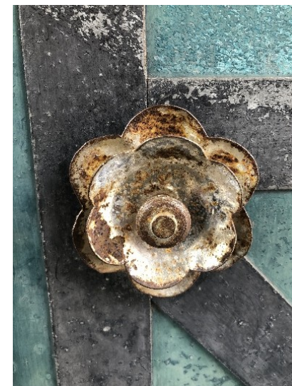
Koroze železa na cínované nádobě a kování
