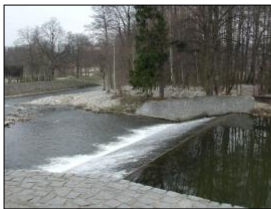
Obr. 13 a 14 Okolí jezů jsou zvláště náchylná k vybřežení. Vlevo zez na Volyňce u soutoku s Peklovem, vpravo jez před ohybem Volyňky pod Volyní
