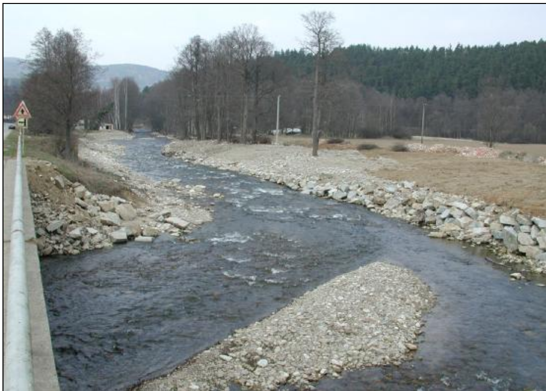
Obr. 7 Antropogenní koryto Volyňky v Bohumilicích bylo během srpnových povodní úplně zničeno, tok přeložil koryto do přímého směru. Snímek zachycuje tok po navrácení do předpovodňového stavu
