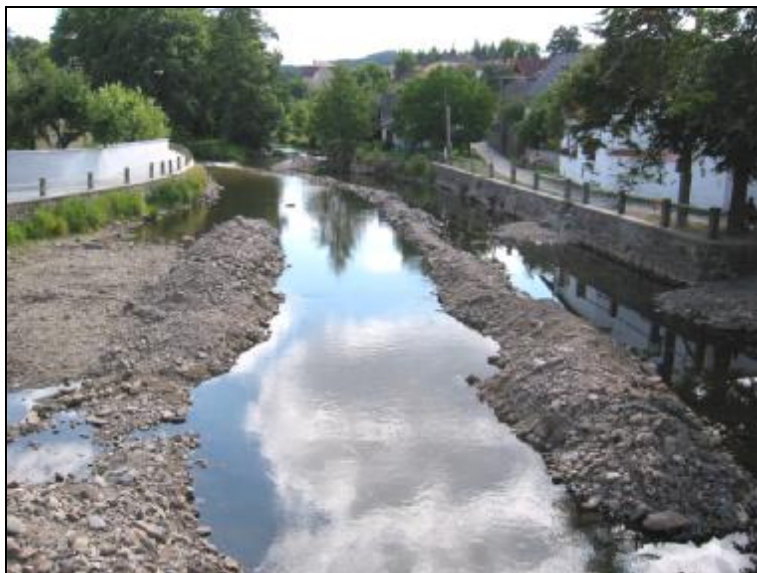
Obr. 11 Rozsáhlé akumulace na Blanici v Husinci, ovlivněné antropogenním zúžením koryta (Foto: J. Langhammer, 2003)
