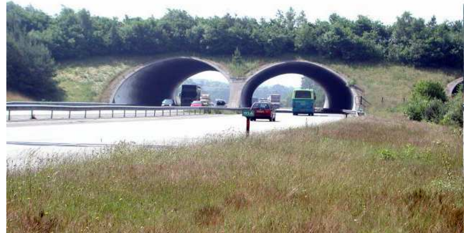
Nadchod pro zvěř na dálnici v Nizozemsku
