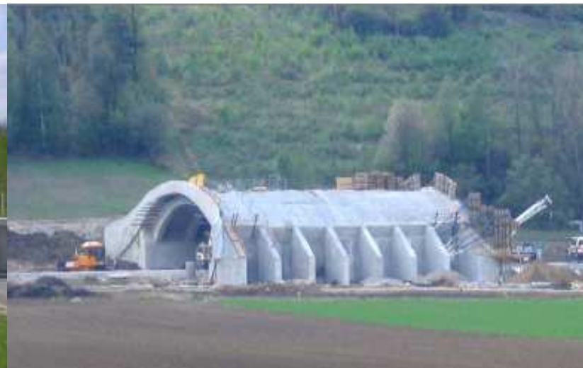
Stavba nadchodu pro zvěř na trati v Dol. Rakousku
