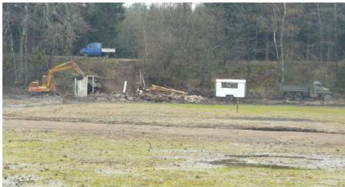
Budování výpustního zařízení
