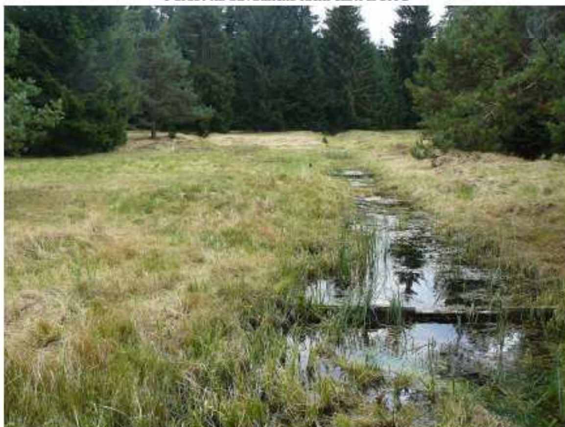
Soustava přehrádek na odvodňovací strouze luční části ZCHÚ
