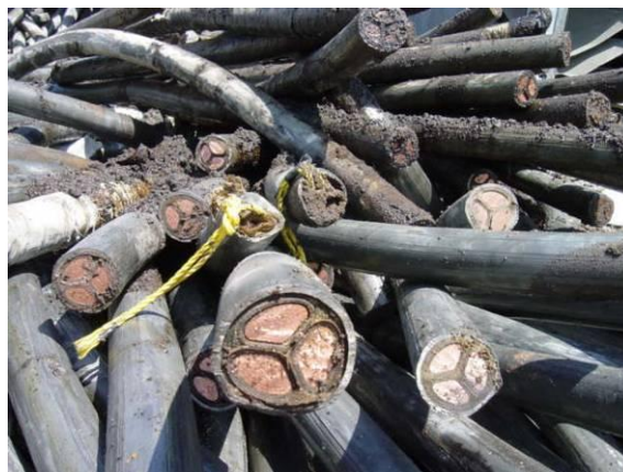
Kapalinou naplněné kabely
