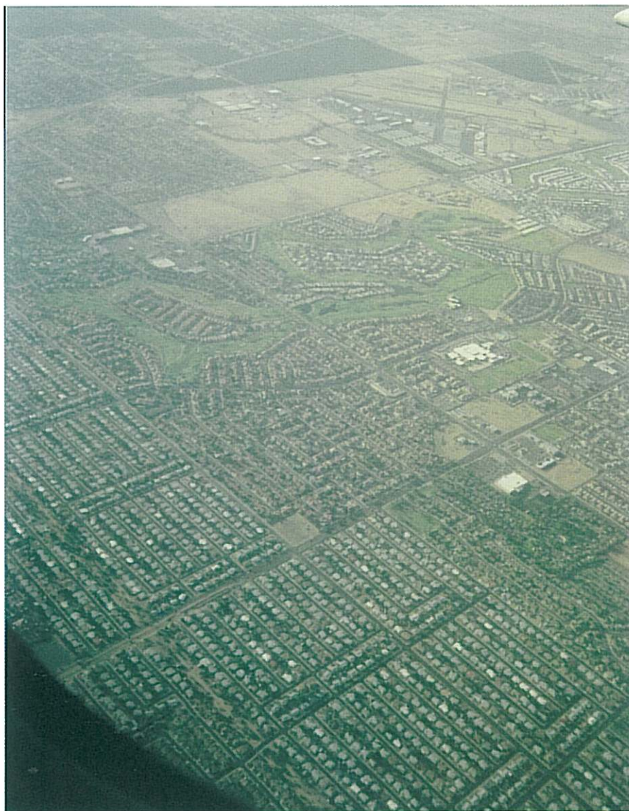
Obr. 4: USA, Phoenix – obytná zóna
