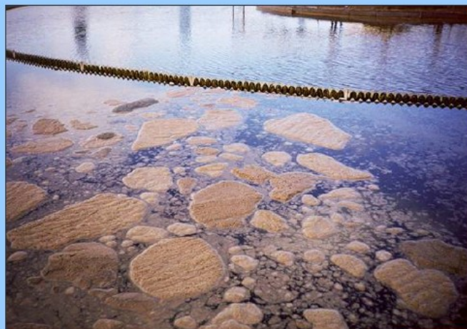
Vzplývání aktivovaného kalu na hladině dosazovací nádrže
