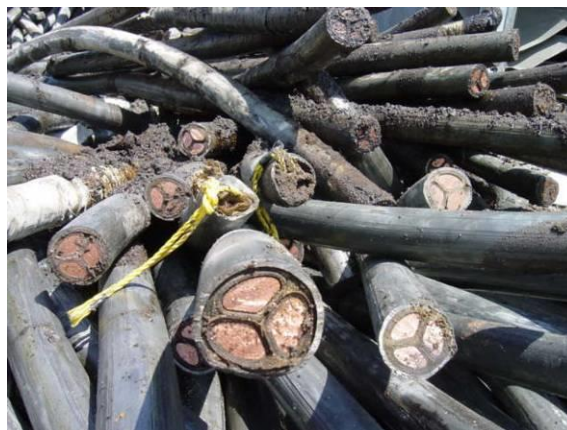
Kapalinou naplněné kabely
