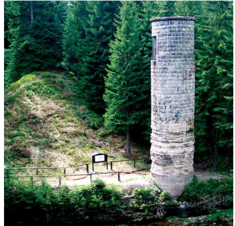
Protržená přehrada na Bílé Desné (1916)
