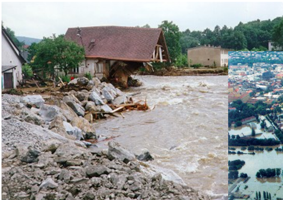
Povodňové škody na Bělé v Mikulovicích
