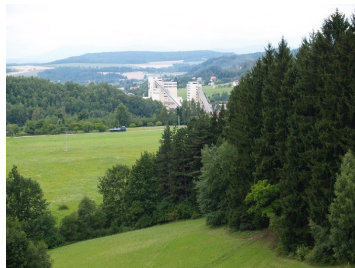
Areál Dolu Z. Nejedlý u Malých Svatoňovic zčásti využit betonárkou
