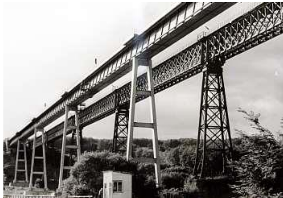
Ivančický viadukt, jeden z prvních celokovových mostů ze svářkového železa a litiny v Rakousko-uherské monarchii, r. 1870 (foto z r. 1978)
