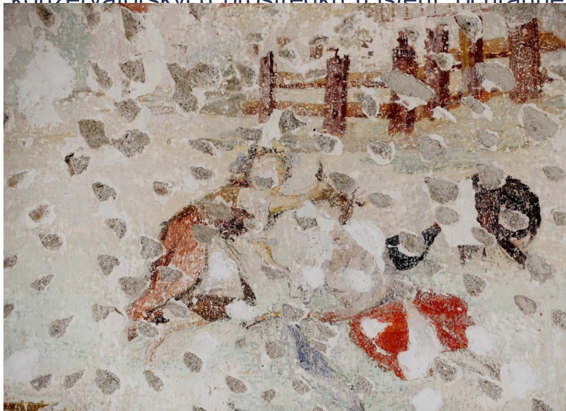
Nástěnná malba s motivy venkovských výjevů z hradu Veverí poškozená tzv. pekováním [10]
