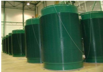
Kontejnery CASTOR pro dočasné uložení použitého jaderného paliva v Dukovanech
