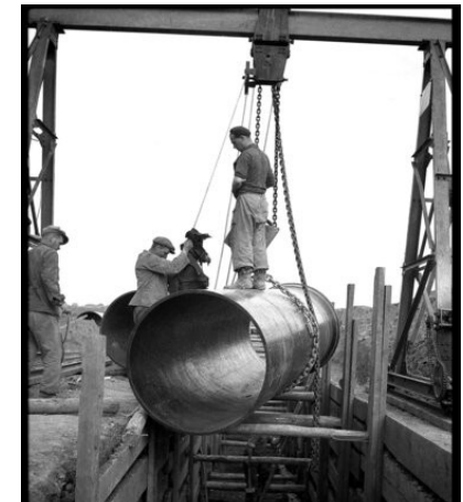
Kladení potrubí, ÚV Káraný (cistavoda.pvk.cz)
