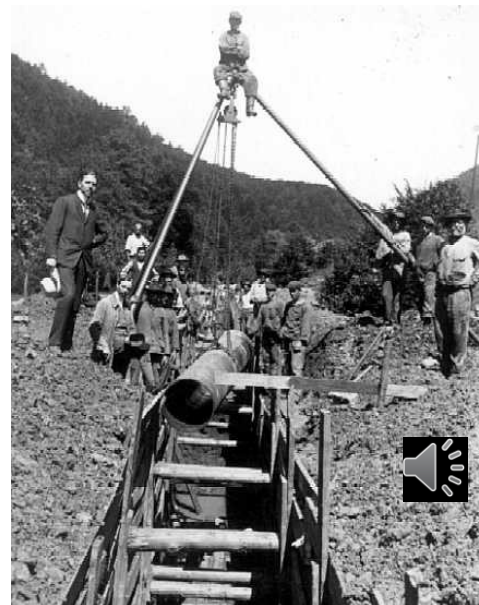
I. březovský vodovod, kladení potrubí, rok 1912 (bvk.cz)
