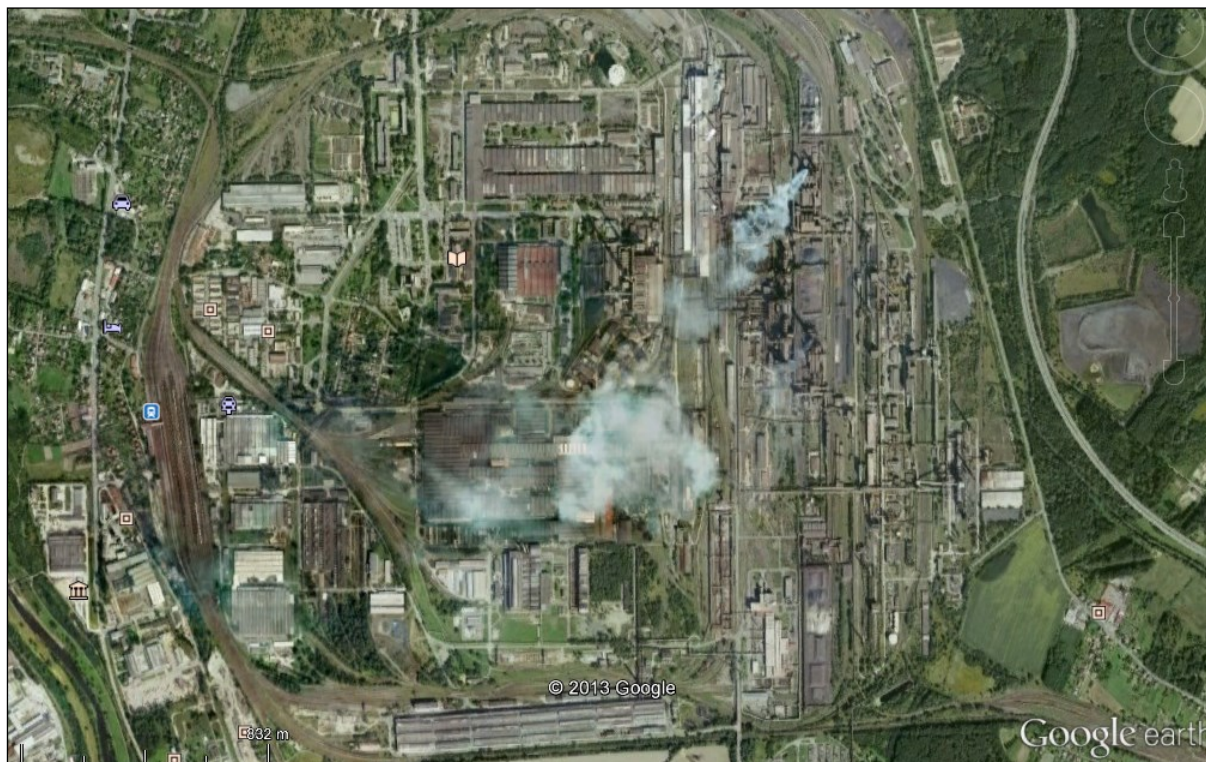
Obr. 53: Ostrava – Kunčice, hutě ArcelorMittal Ostrava, a.s. Zdroj: Google Earth.
