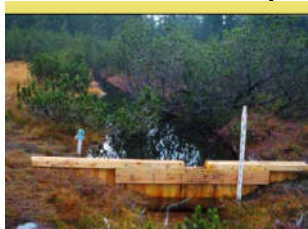
hráze z fošen - zarážené vertikálně
