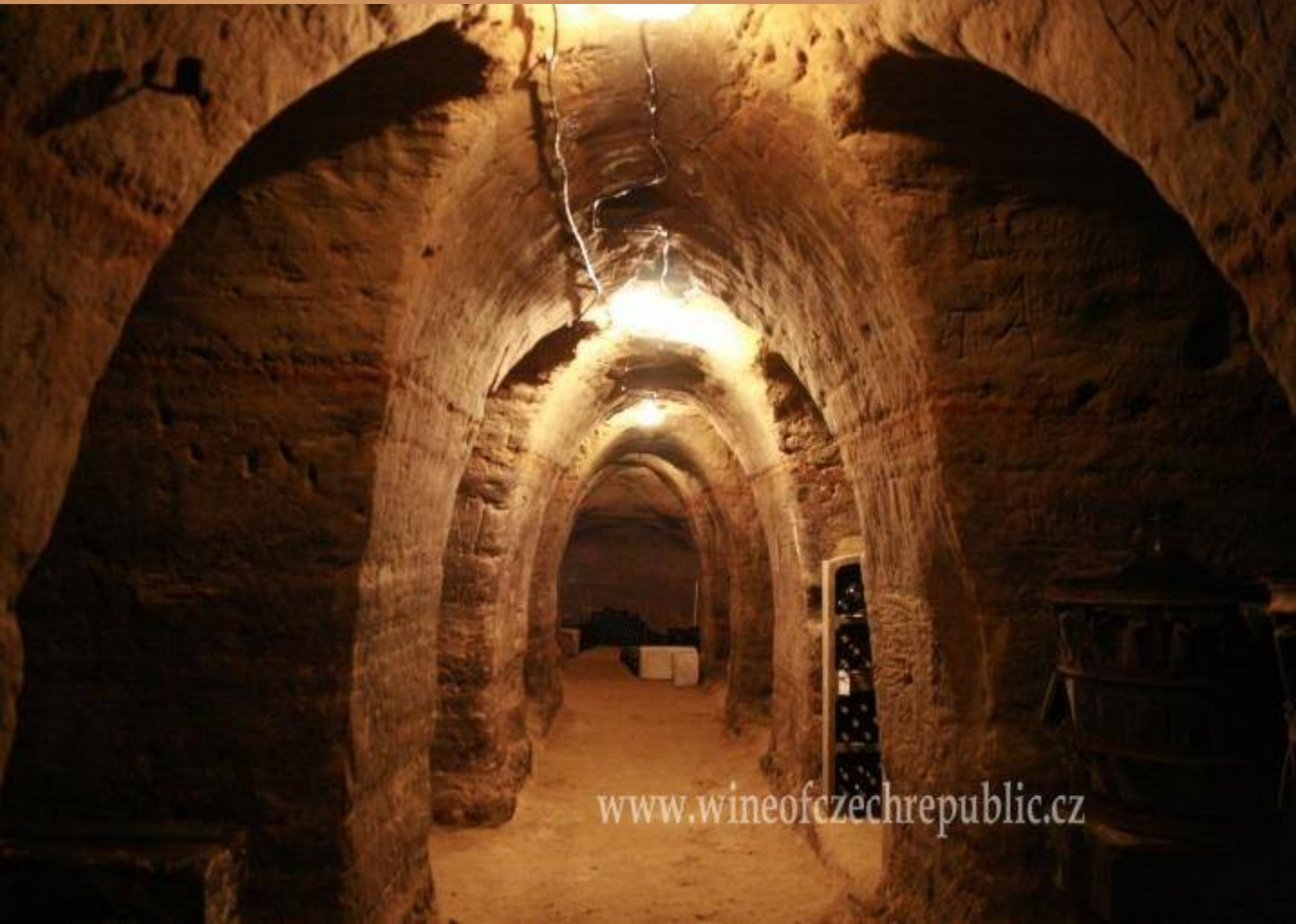
Vinný sklep v Olbramovicích vykopaný v miocénním písku
