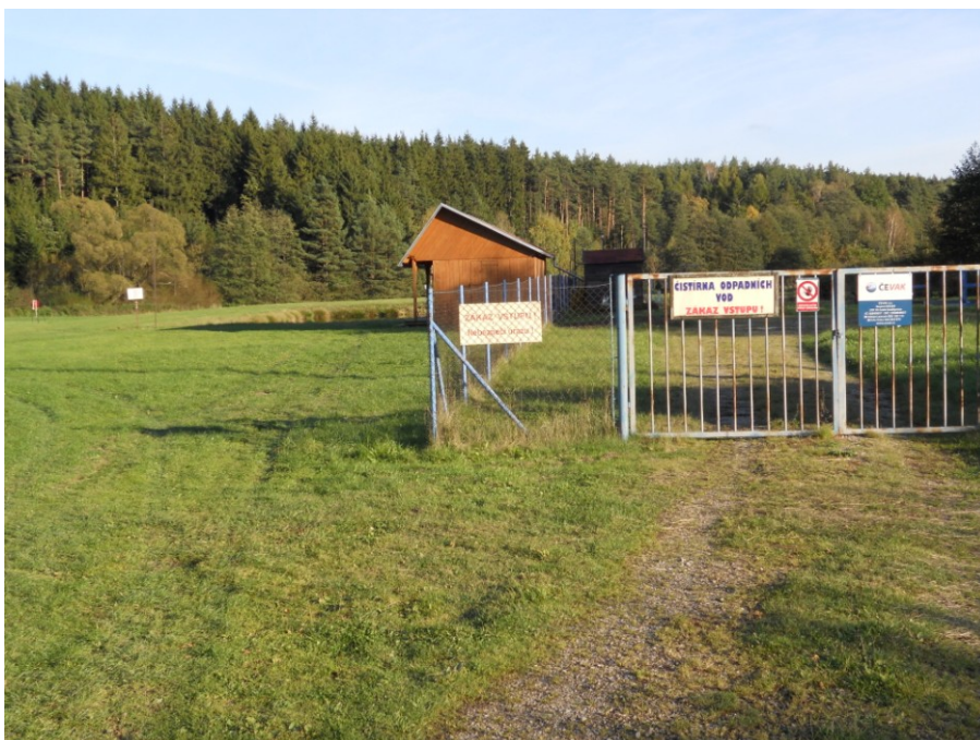
Obr. 23 Čistírna odpadních vod pod obcí Český Rudolec
