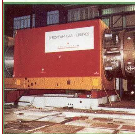
Montáž plynové turbíny č. 1 na základy
