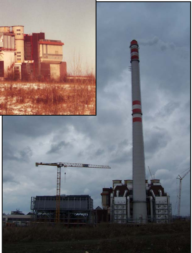
Spalovna ZEVO Malešice v průběhu stavby kogenerační jednotky a zařízení DeNOx (21. 3. 2010)
