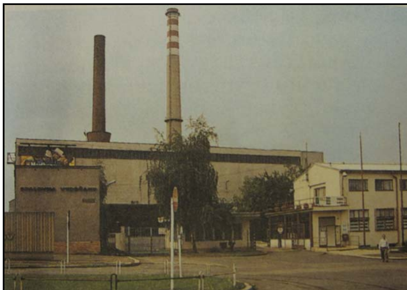
Spalovna Vysočany před ukončením provozu
