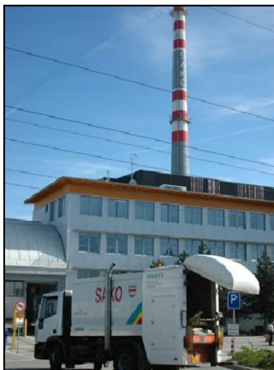
Spalovna a komunální odpady (SAKO) v Brně před rekonstrukcí
