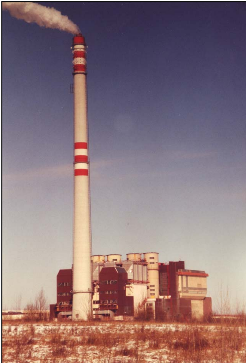
Spalovna ZEVO Malešice před stavbou dedioxinové technologie (2003)
