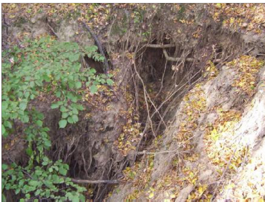
Foto 16: Propadnutí stropu sufozní dutiny 5b (foto: M. Hořáková, 23. 10. 06)
