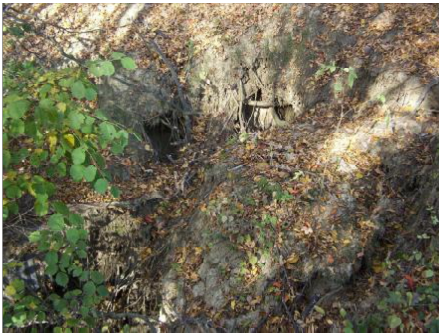
Foto 15: Pohled shora na sufozní dutinu 5b (foto: M. Hořáková, 29. 10. 05)
