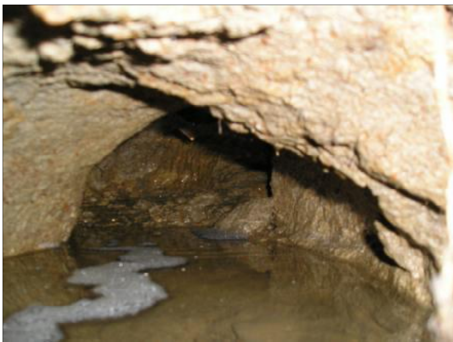
Foto 12: Detail podzemního prostoru sufozní dutiny 3a (foto: M. Hořáková, 29. 3. 07)
