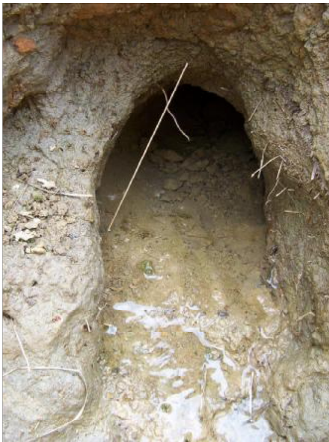
Foto 11: Vytékající voda ze sufozní dutiny 3a (foto: M. Hořáková, 8. 4. 06)
