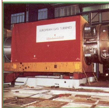
Montáž plynové turbíny č. 1 na základy
