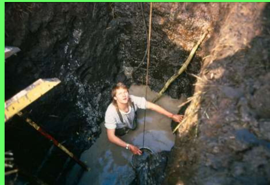
Foto: P.Pokorný Švarcenberk (Třeboňsko) - výkop
