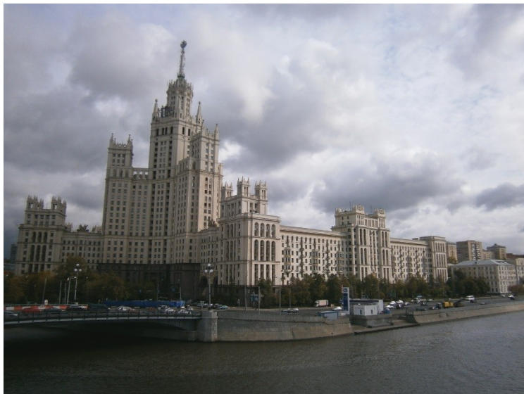
Palác na Kotelničeském nábřeží (Высотка на Котельнической набережной) 1952, 176m
