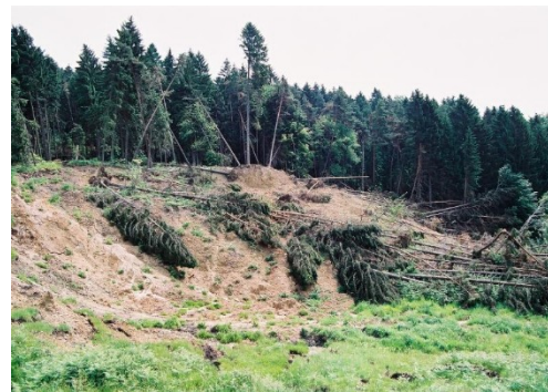
Střední transportní část svahové deformace
