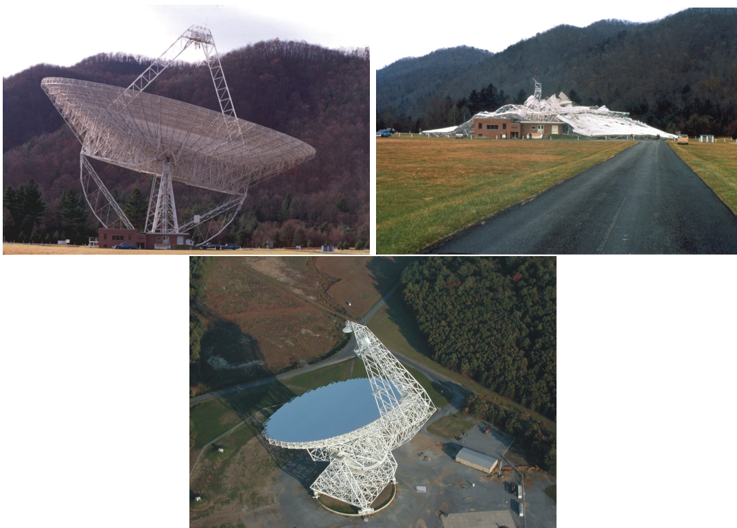
Obrázek 11.4: Nahoře: Původní velký radioteleskop v NRAO, Green Bank, 15. listopadu 1988 a vpravo následující den, po zhroutilí. Dole: Zničený radioteleskop nahradil nový přístroj – Robert C. Byrd Green Bank Telescope. Foto: Richard Porcas, NRAO.
