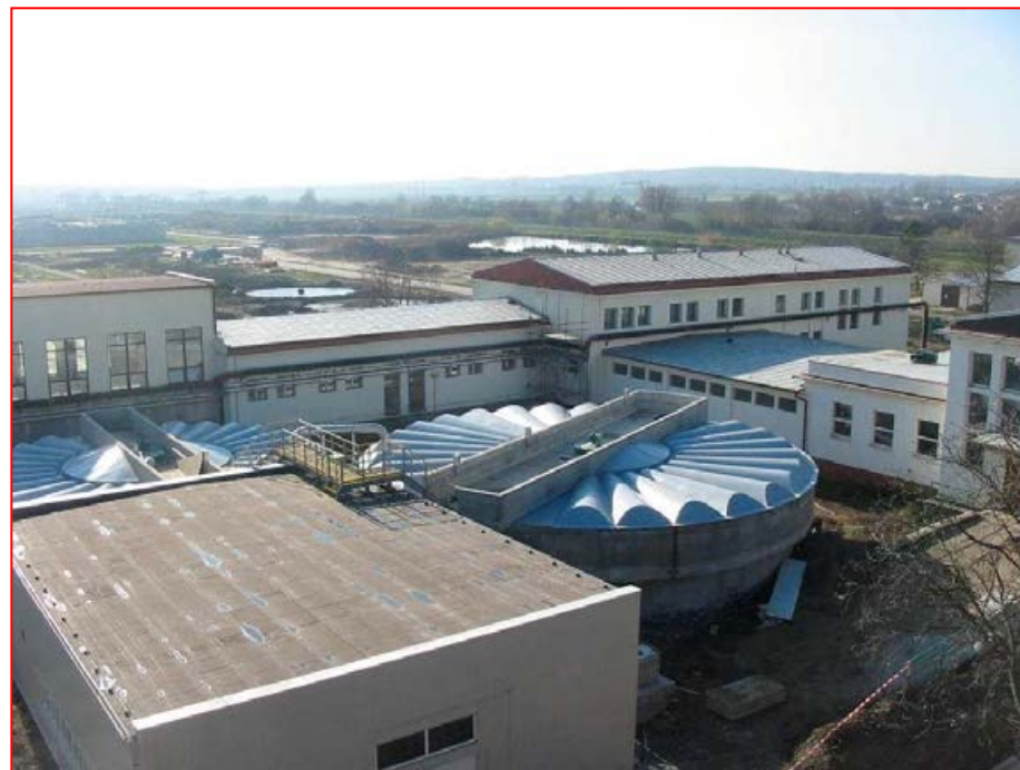
Zahušťovací nádrž, Flotační jednotka ČOV Brno - Modřice
