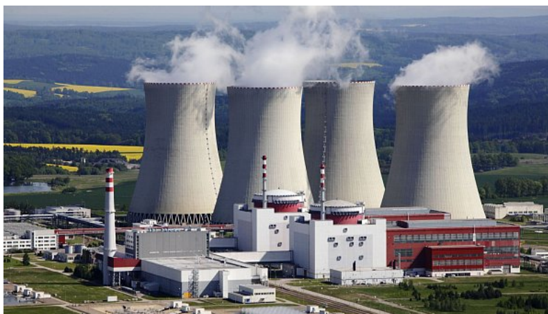
Chladící věže jaderné elektrárny Temelín
