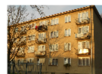
soustavy T018,028,038 do konce 60. let tzn. blokové panely (jak chci, tak z betonu) dávají i na venkově
