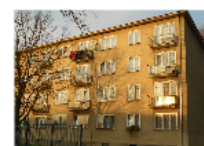
soustavy T018, 028, 038 do konce 60. let tzn. blokové panely (jak chci, tak z betonu) dávají i na venkově
