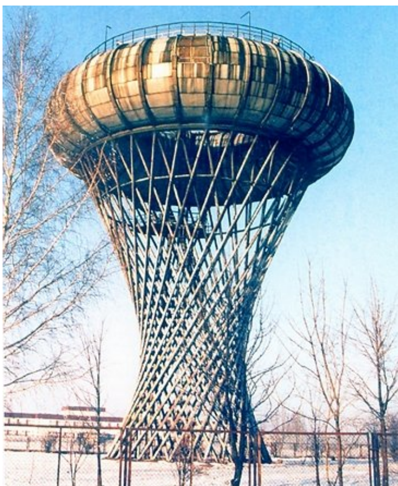
Vodojem na okraji Ciechanowa, Polsko
