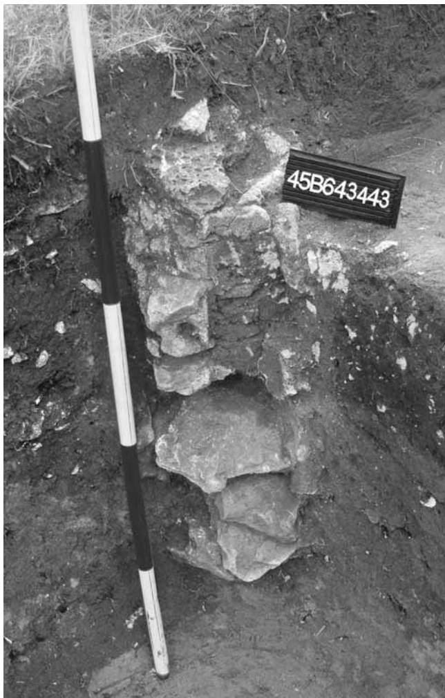
Obr. 45. Pohansko u Břeclavi - SV předhradí, kostel č. 2. Řez otiskem nosného sloupu ve zdivu apsidy se základem tvořeným volně loženými kameny (foto: archiv ÚAM FF MU). — Fig. 45. Pohansko near Břeclav - NE suburb, church no. 2. Cross-section of load-bearing posts in the masonry of the apse with dry-stack stone foundation (photo: archive of the Department of Archaeology and Museology in the Faculty of Arts at Masaryk University).
