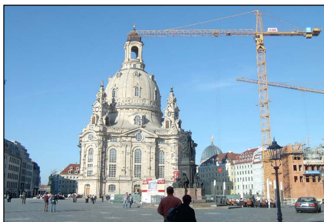
Obr. 8 - Celkový pohled na opravenou katedrálu Frauenkirche v roce 2010. Fig. 8 – General view of the repaired Frauenkirche cathedral in 2010.
