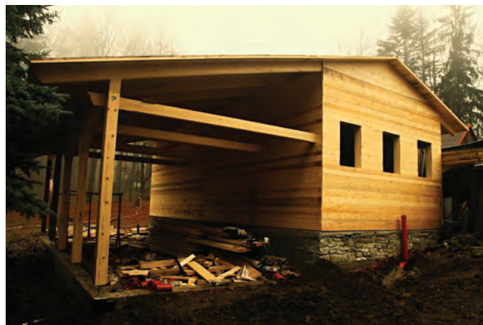
Obr. 2. Pokročilá výstavba budovy nových veřejných záchodů se splachováním na dešťovou vodu, říjen 2017 (foto V. Kalníková)
