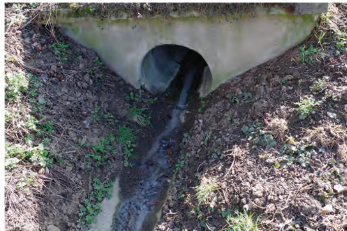
Obr. 3. Vyústění kanalizace pod obcí Svinošice v horní části povodí Kuřimky
