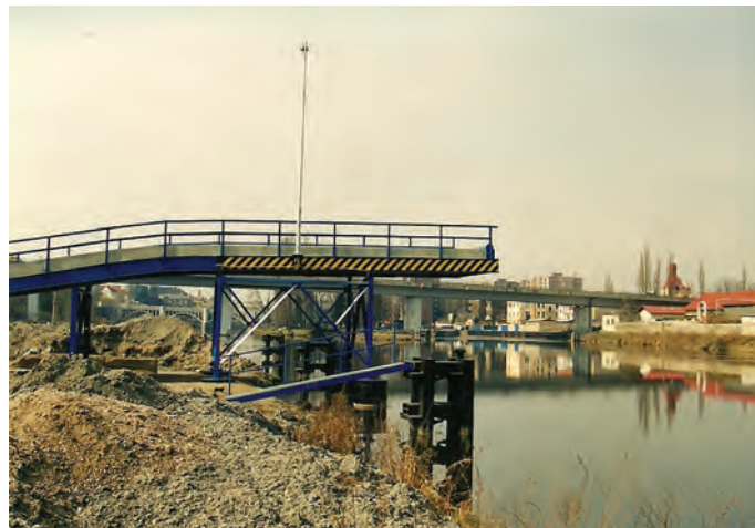
Obr. 8. Kapacitní rampa pro jednoduchý a kapacitní překlád ze „sklápěček“ přímo do člunů v Kolíně. Zvládla by jistě nakládku až 1 mil. t/rok. Objem překládky v tomto koncovém přístavu labské vodní cesty je však – nulový
