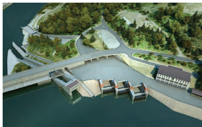
Obr. 2. Vtokový objekt hrazený třemi segmentovými uzávěry [2]
