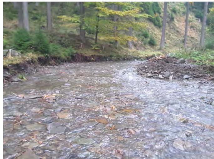
Obr. 10. Lokalita po zásahu v korytě – vytvoření antropogenní dnové dlažby (foto Miroslav Kubín)
