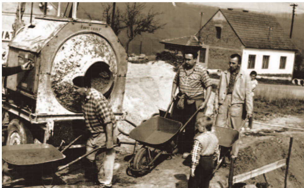
Obrázek 2: Brigáda na stavbě kulturního domu v Rokytné, 1973, soukromý archiv narátora pana K.
