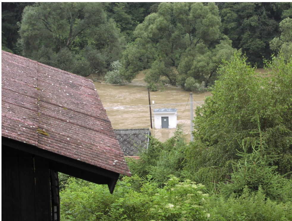
Obr.1 - Podhradí nad Dyjí - zaplavená vodoměrná stanice
