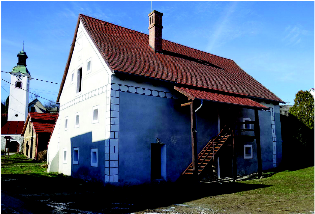
Obr. 9. Habánsky mlyn z roku 1716. Základy a najstaršie stavebné prvky pochádzajú zo 16. storočia. Pôvodný objekt zničila povodeň v roku 1672. Foto: P. CHRASTINA (II/2021).
