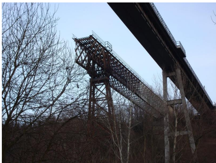
Obr. 20 Zbytek Ivančického viaduktu. V současnosti je používán vedlejší modernější most. (Panoramino, 2012)
