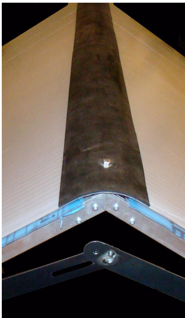
Obrázek 15 – Spojení dvou kusů střechy pomocí gumy
